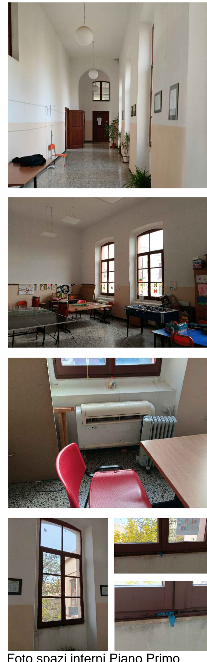
Foto spazi interni Piano Primo
