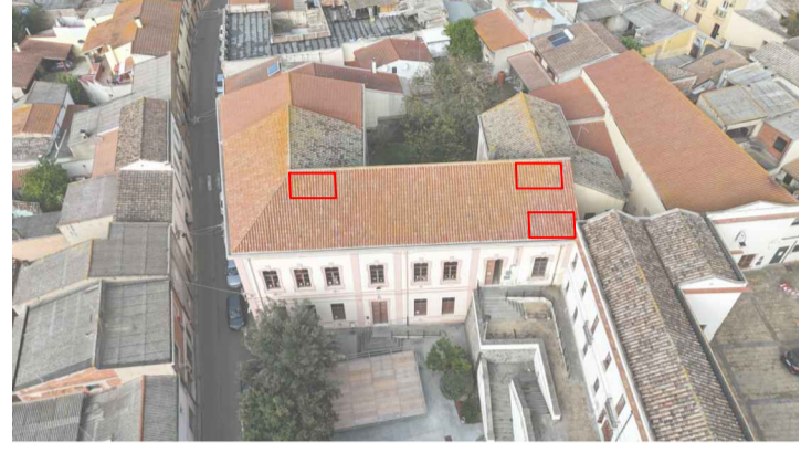
D - Riparazione manto di copertura in coppi (SAR24_PF.0012.0026.0023)
