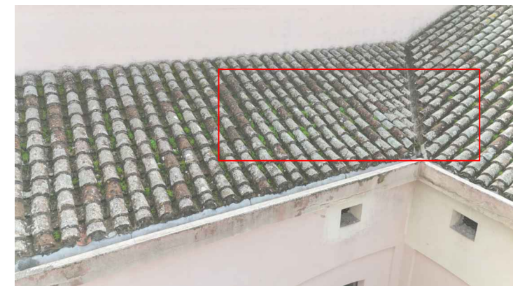
C - Pulizia manto di copertura e canali di gronda (GL24_PUL.002 e GL24_PUL.003)
