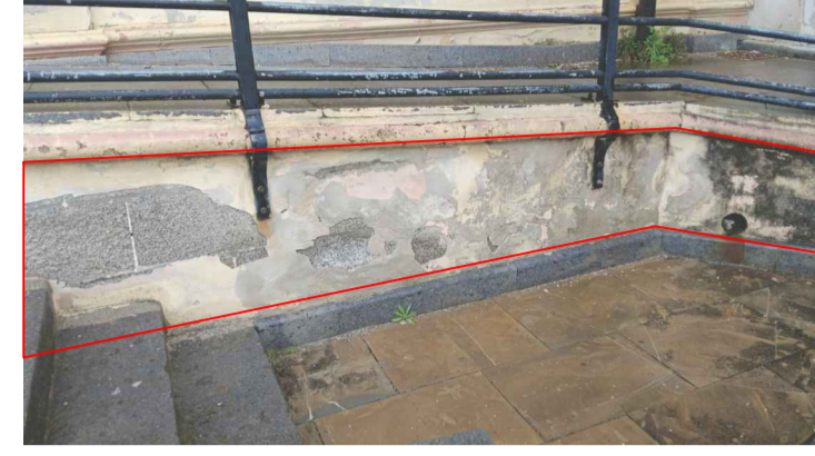
F - Rimozione finitura e nuova rasatura (SAR24: PF.12.8.7, PF.13.4.71, PF.13.5.7)
