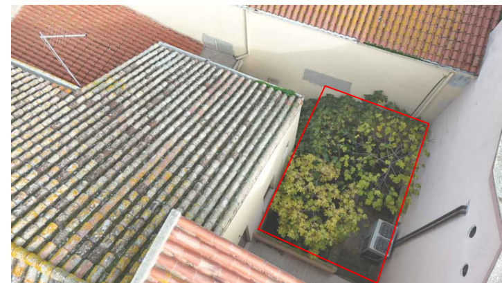
B - Pulizia straordinaria cortiletto esterno e bonifica igienico-sanitaria (GL24_RIS.001)
