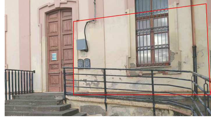
E - Spicconatura, intonaco e tinteggiatura (SAR24: PF.12.8.1, PF.13.4.47, PF.13.5.7)
