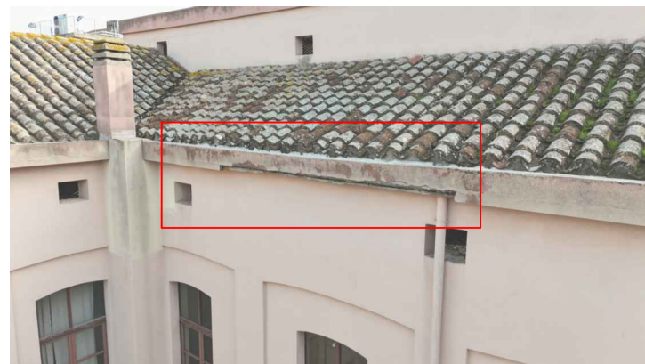
A - Risanamento cornice in calcestruzzo - lato cortile CPF 6 (SAR24_PF.0012.0024.0002)
